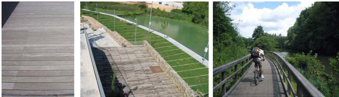
Platelages BWA à l'air libre au dessus de l'eau et hors sol (à 30cm minimum) :
