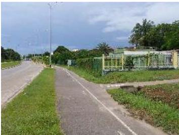
Ce sont des infrastructures réservées aux cyclistes et séparées physiquement de la chaussée utilisée par les véhicules à moteur. La séparation peut être limitée à une bordure surélevée s'opposant aux franchissements volontaires, ou constitué par une surface engazonnée, voire plantée
